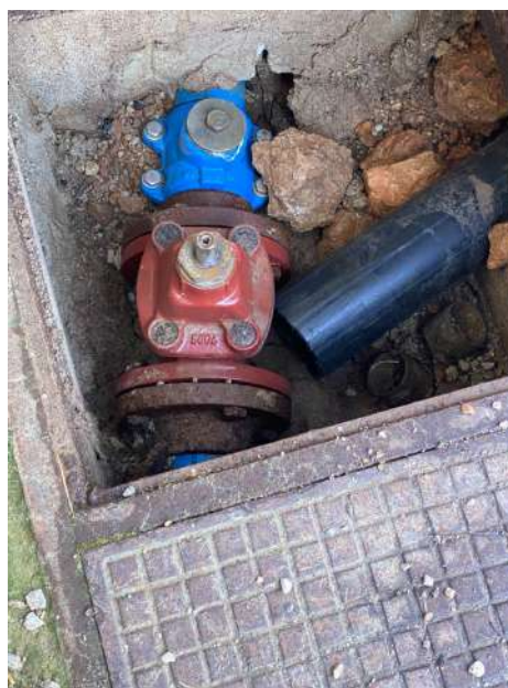
14 - Detall Registre canonada principal Ses Mosqueres i Font de la Vila
