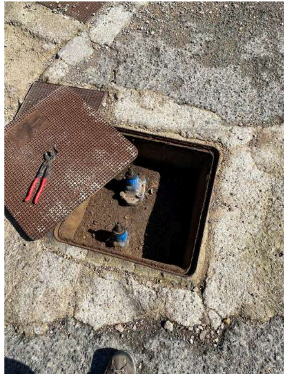
22 - Detall registres entrada al Dipòsit
