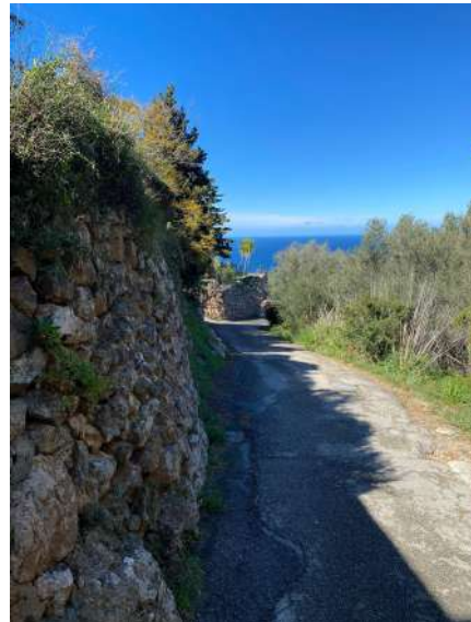
36 - Camí per on discorre la conducció del Dipòsit de Ses Roquetes
