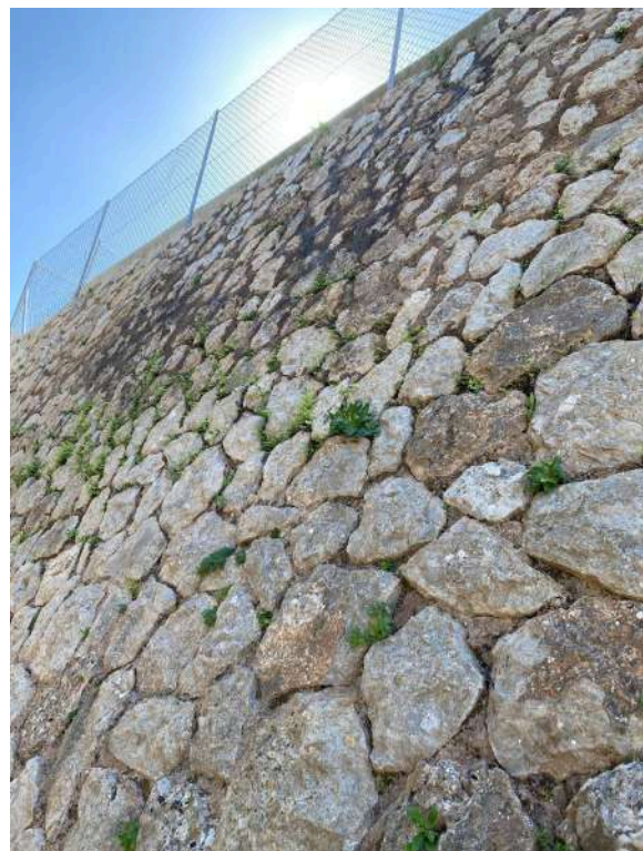
24 - Mur dipòsit Ses Roquetes
