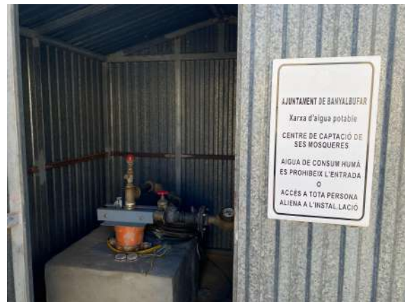
4 - Exterior captació de Ses Mosqueres
